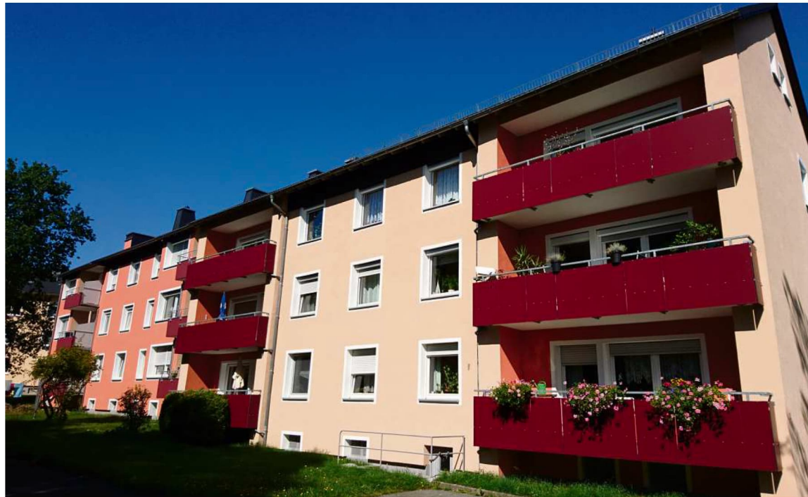
Die Münchberger Baugenossenschaft modernisiert Stück für Stück ihre Gebäude, wie hier in der Gartenstraße 39/41.
